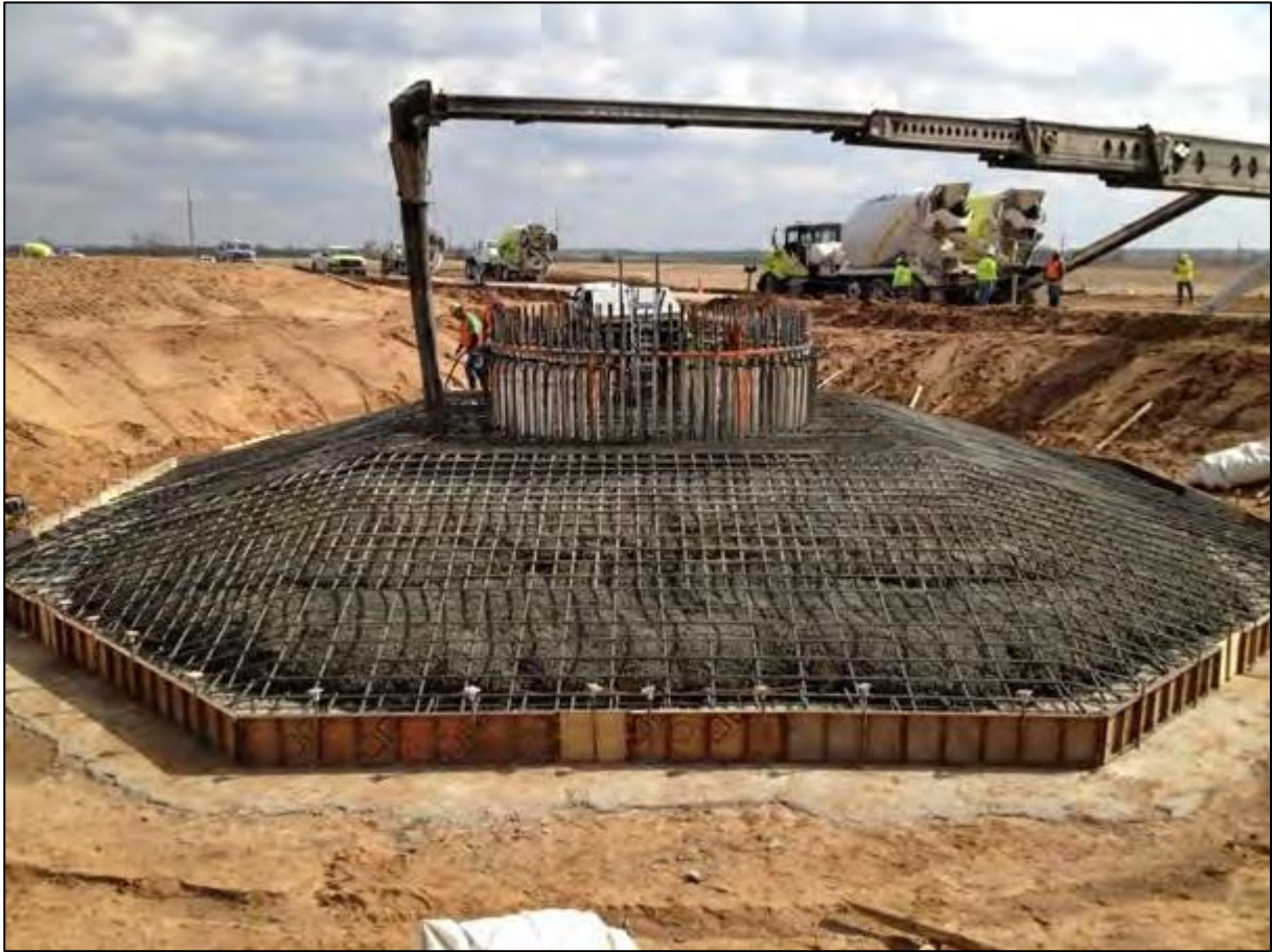
Obrázok 6: Teleso základov VtE z armovaného betónu
